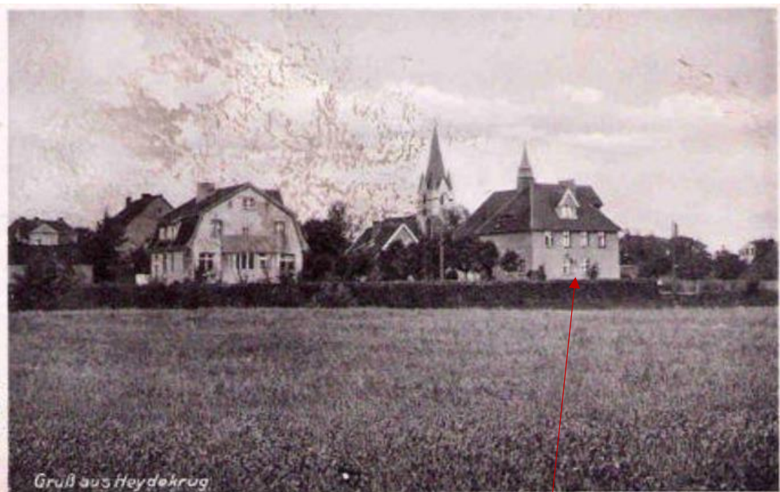
Šilutės krikščionių bendruomenės koplyčios pastatas / XX a. I pusė
