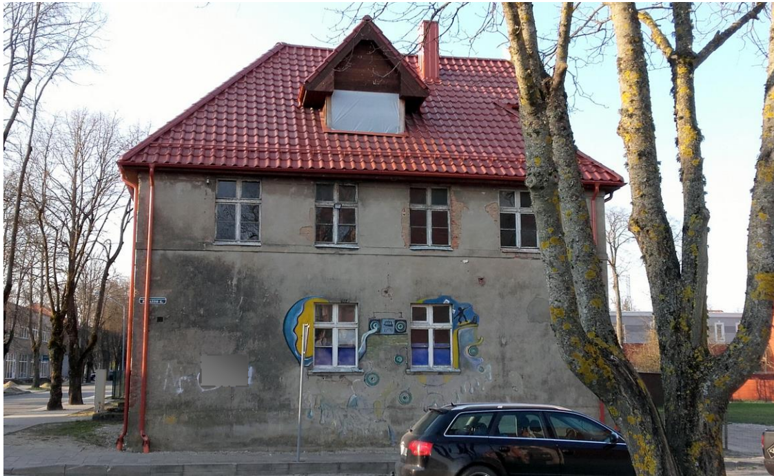
Šilutės krikščionių bendruomenės koplyčios pastatas (32981) / Vaizdas iš P. Jakšto g. / P fasadas / 2019-04-12 / Liepų g. 7 / Šilutė
