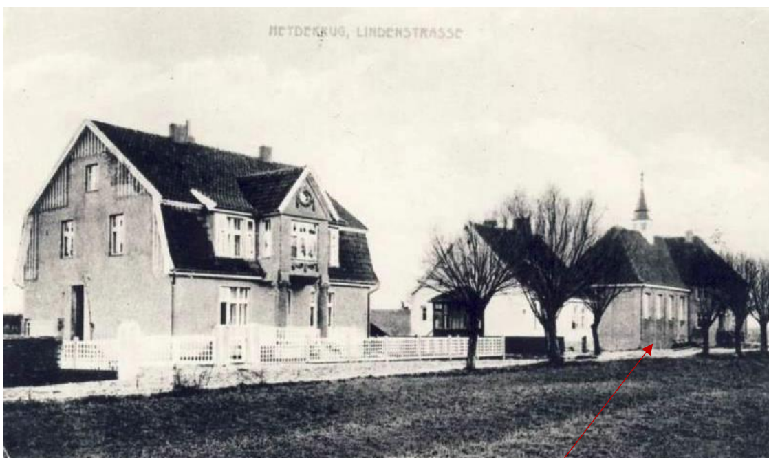
Šilutės krikščionių bendruomenės koplyčios pastatas / XX a. I pusė
