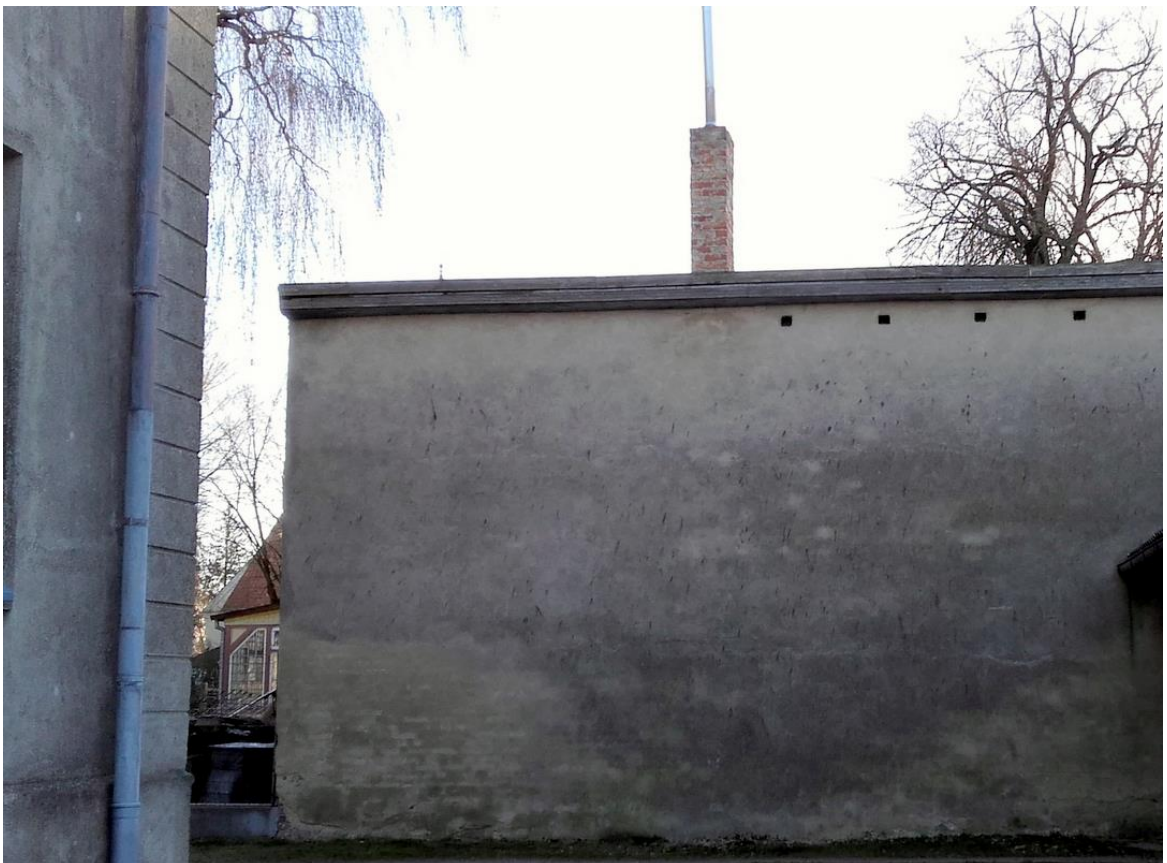
4. Pastatų komplekso ūkinis pastatas (36085) / Š fasadas / K. Kalinausko g. 6 / 2020-02-14
