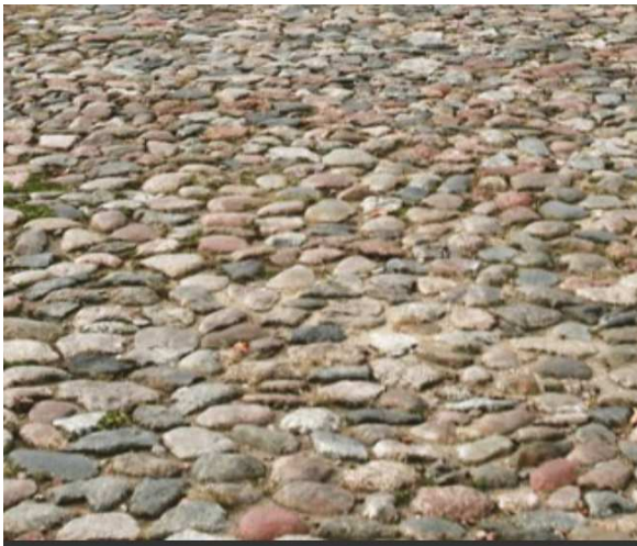
7 pav. Projektuojamos Gudobelių alėjos važiuojamoji dalis iš lauko riedulių.
