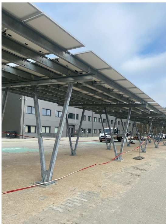
1 pav. Metalinės konstrukcijos vizualizacija su saulės moduliais
