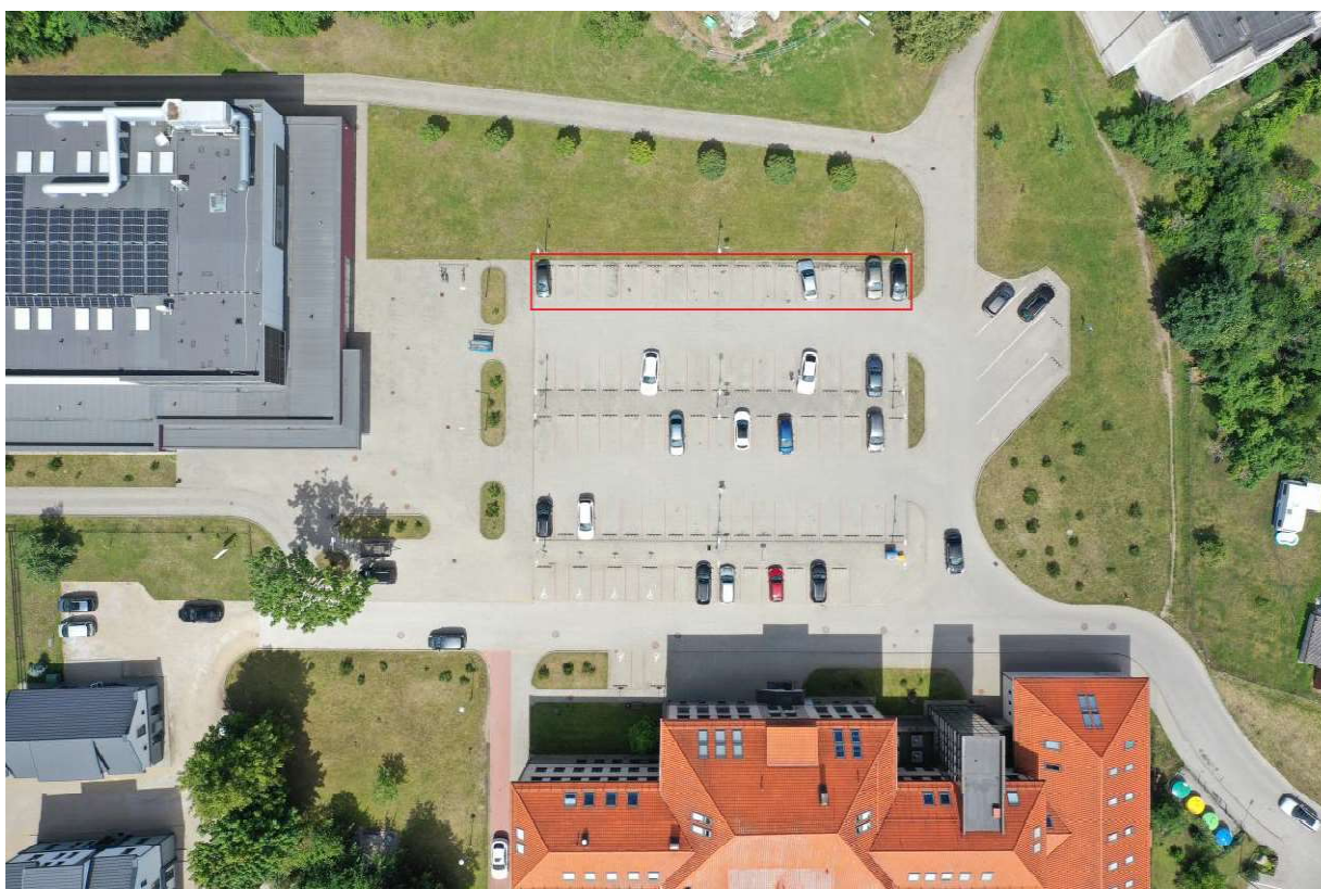
2 pav. Žemės sklypo nuotrauka. Raudonai pažymėta vieta kur numatoma statyti metalinę konstrukciją.
