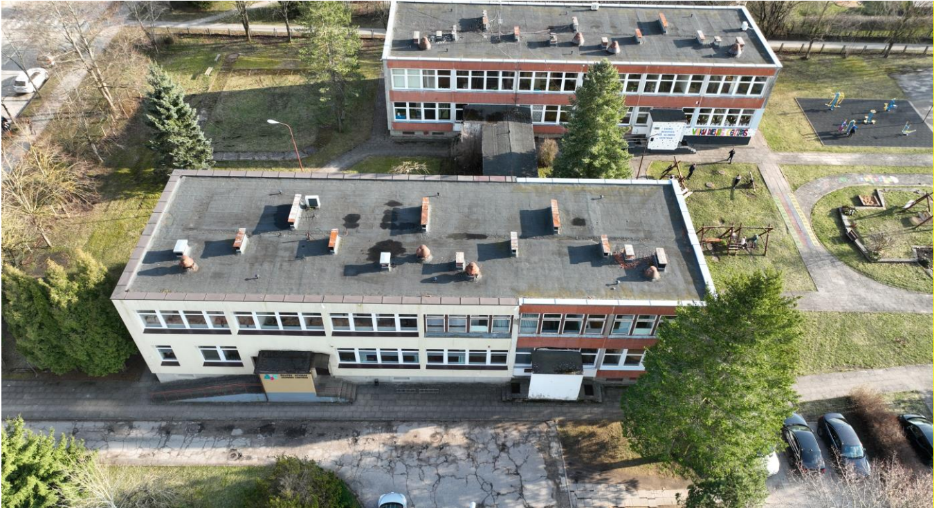
Esamos padėties fotografacijos - esamo mokslo paskirties pastato (unik. Nr. 8898-7002-1010) šiaurinės pusės vaizdas
