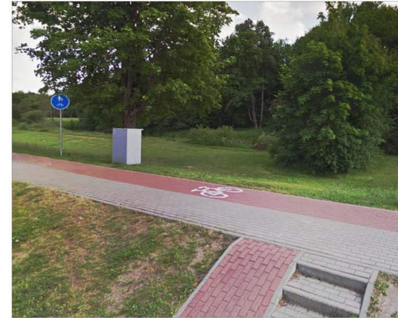
Pėsčiųjų tako pavyzdys. Pėsčiųjų ir dviračių takai atskiriami tarpusavyje kitos spalvos trinkelėmis, vertikaliuoju ir horizontaliuoju kelių ženkliniu.
